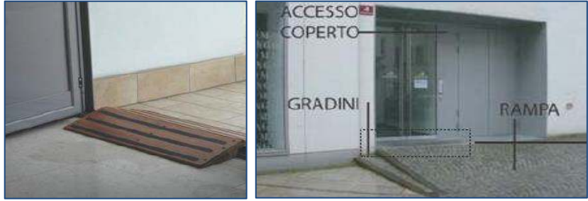
Figura 25e Figura 26 - Esempi di rampa di collegamento
